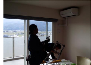
エアコンの取付
