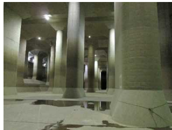
写2 「地下神殿」と呼ばれる 巨大な調圧水槽
