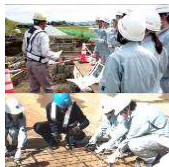
工事現場見学と鉄筋結束体験
