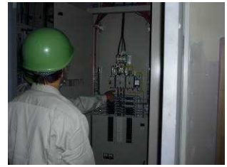
大和電建(株)実習風景
