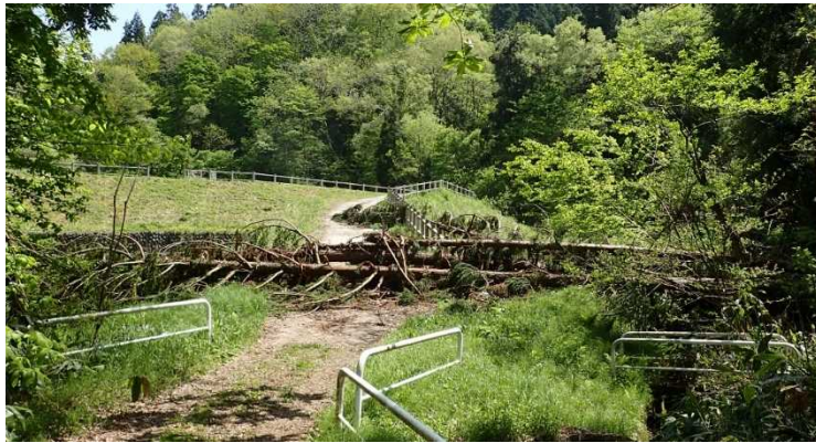
写真 16 強風による倒木被害
