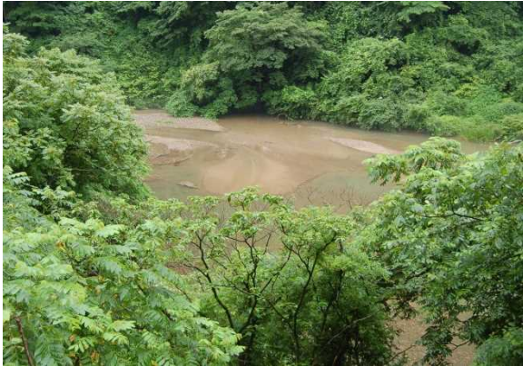
写真3 ダムへの土砂流出
