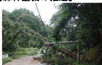
倒木により電線断線
