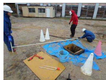
図8 掘削距離確認
