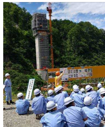
図 1 国道 289 号線工事 (三条市)
