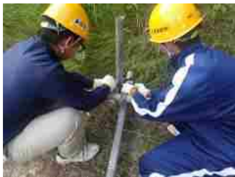
建設業でのインターンシップ
