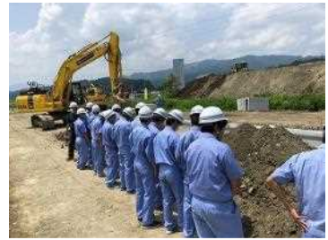
図1 上沼道バイパス工事(南魚沼市)
