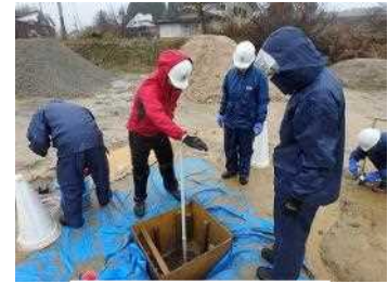
図5 先孔延長工事
