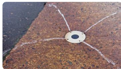
道路の消雪パイプ
