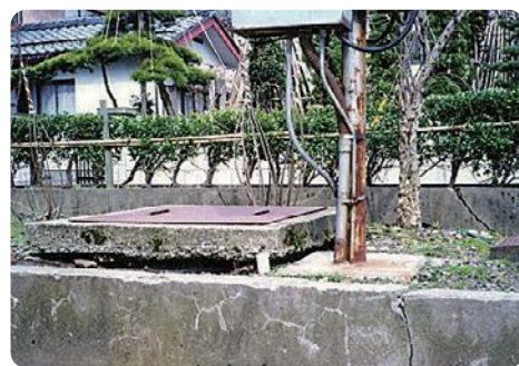
消雪用井戸のボックスの抜け上がり
