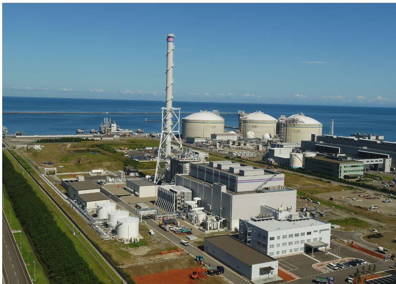
上越火力発電所の全景
