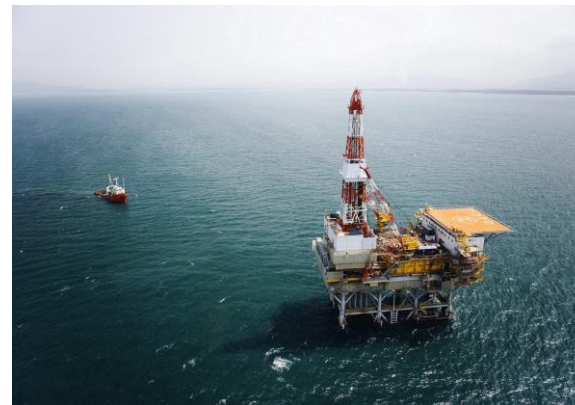
上写真： 岩船沖油ガス田 海上プラットフォーム
