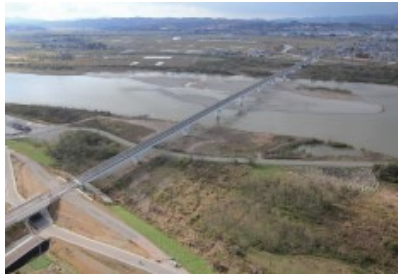
一般国道404号 フェニックス大橋 (長岡市)
