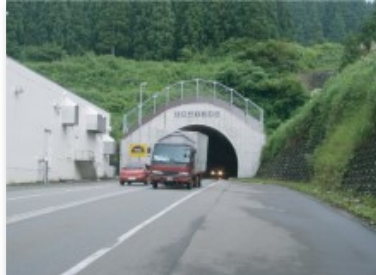
主要地方道十日町当間塩沢線 大沢山トンネル (十日町市～南魚沼市)
