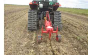
補助暗渠の施工 (サブソイラー)
