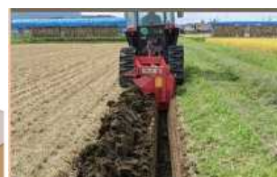
周囲明渠の施工 (溝掘機)
