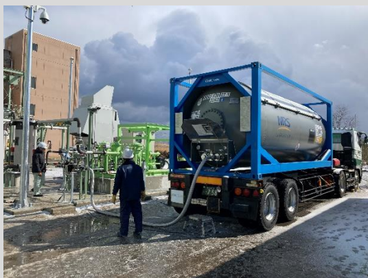
【写真2-1-33】 消化ガス供給の様子
