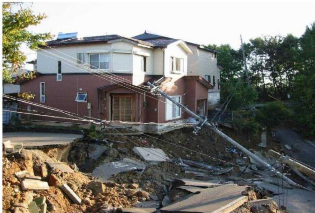
新潟県中越地震の被害
