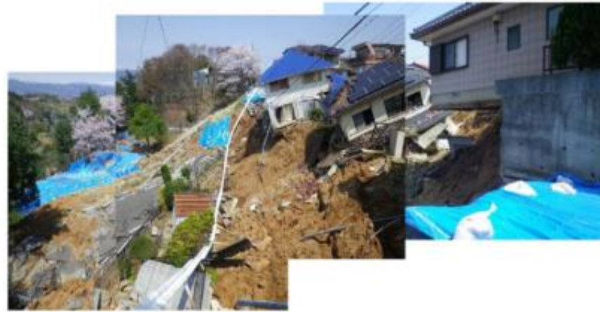
(d)液状化による側方流動の事例
