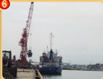
中央埠頭 1号岸壁
