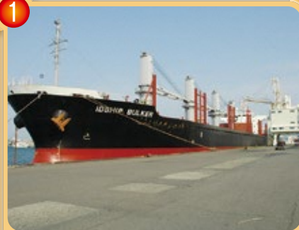
西埠頭 1号岸壁
