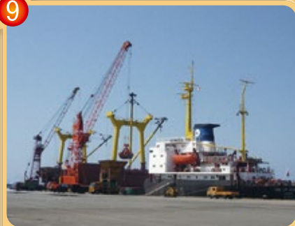
中央埠頭 鈦産品岸壁
