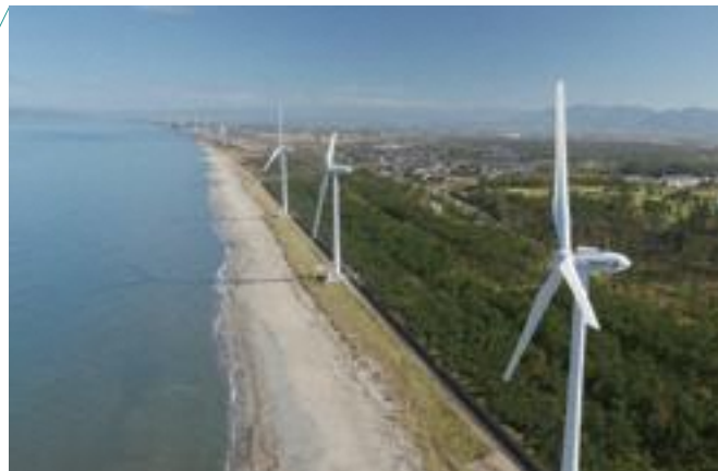
JEN 胎内ウインドファーム(株) 胎内風力発電所 (胎内市村松浜・中村浜・笹口浜付近)
