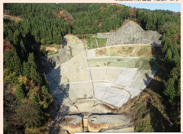
地すべり防止工事による復旧状況
