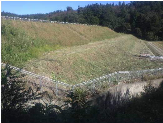
【ため池耐震工事前】
