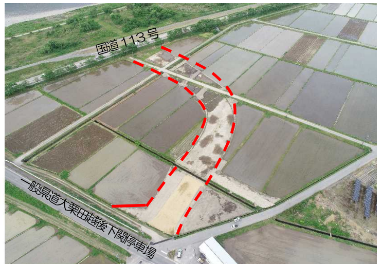
一般県道大栗田越後下関停車場線（アクセス道路整備）
