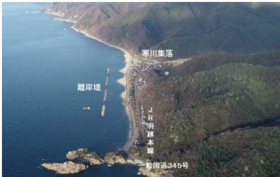
寒川地区海岸の侵食対策
