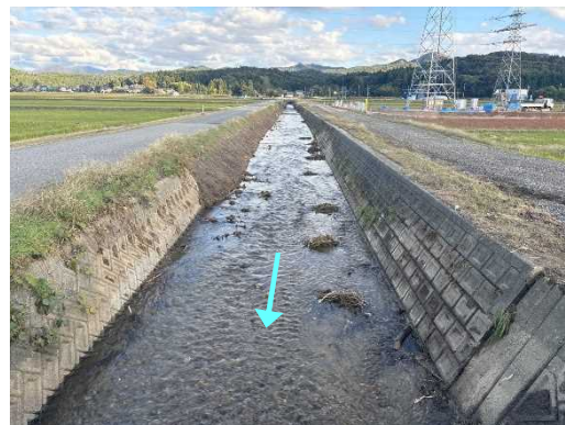
堀川 河道掘削後
