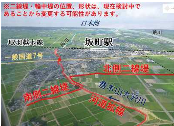
坂町地区の浸水対策（春木山大沢川ほか）
