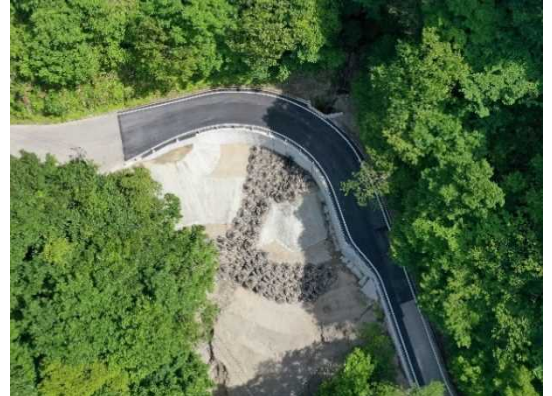
復旧工事完了
