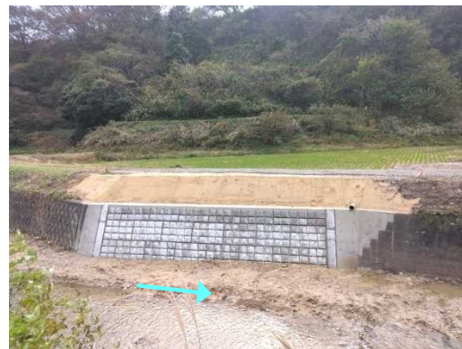
大川（柏尾）護岸工事後
