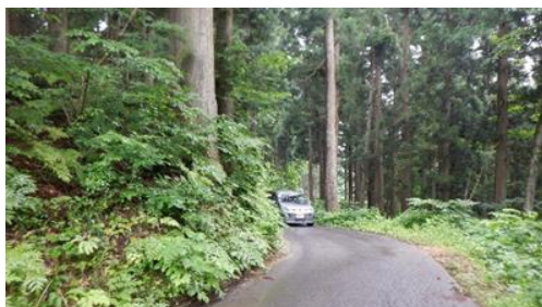
視距が悪く幅員も狭い状況
