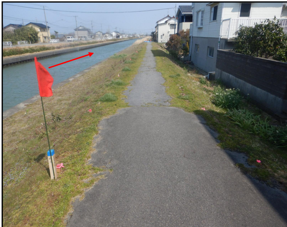
令和6年3月15日 右岸側 終点から下流を望む
