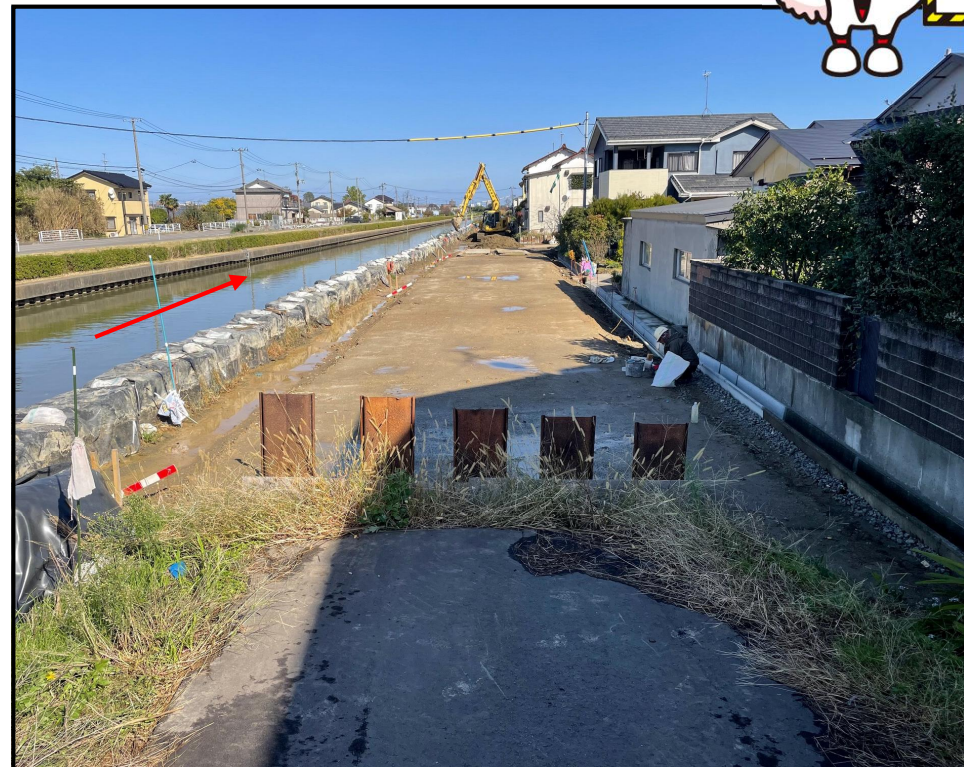
令和7年11月4日 右岸側 終点から下流を望む
