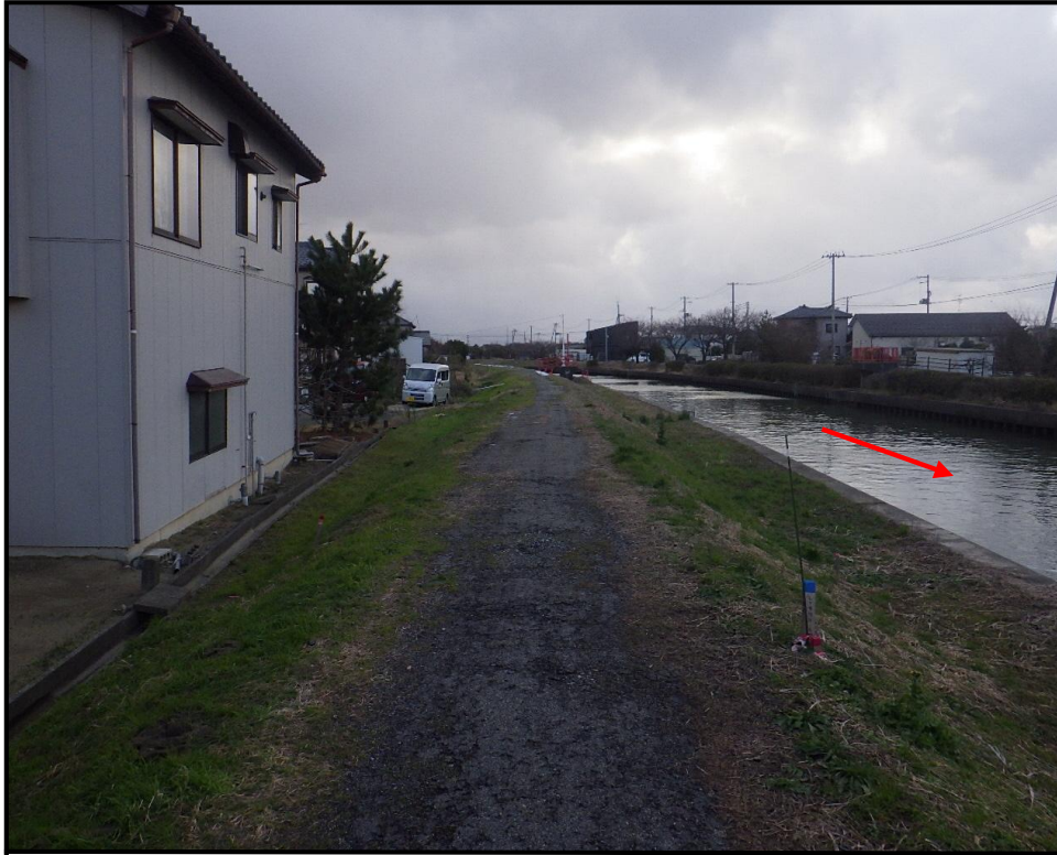
令和6年12月27日 右岸側 起点から上流を望む
