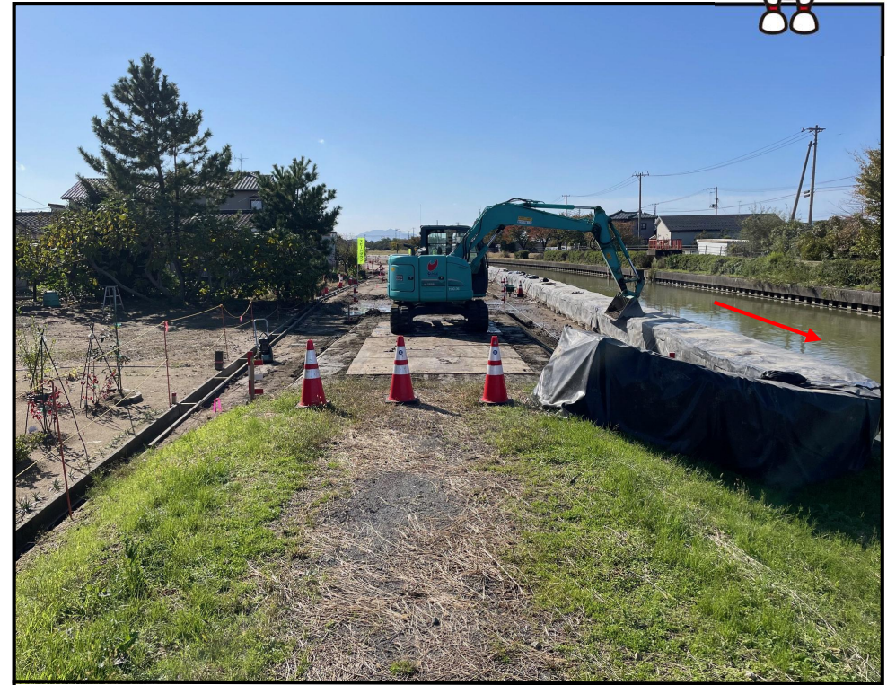
令和7年11月4日 右岸側 起点から上流を望む
