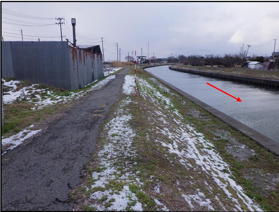
令和7年1月20日 右岸側 起点から上流を望む
