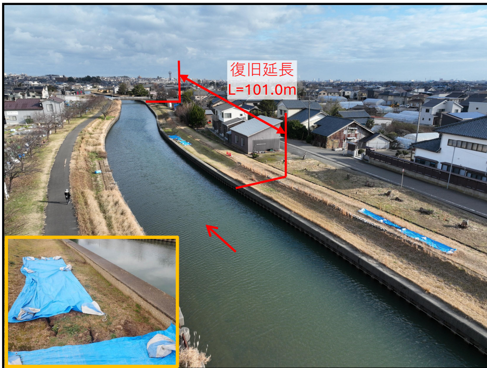
令和6年12月25日 右岸側 終点から下流を望む
