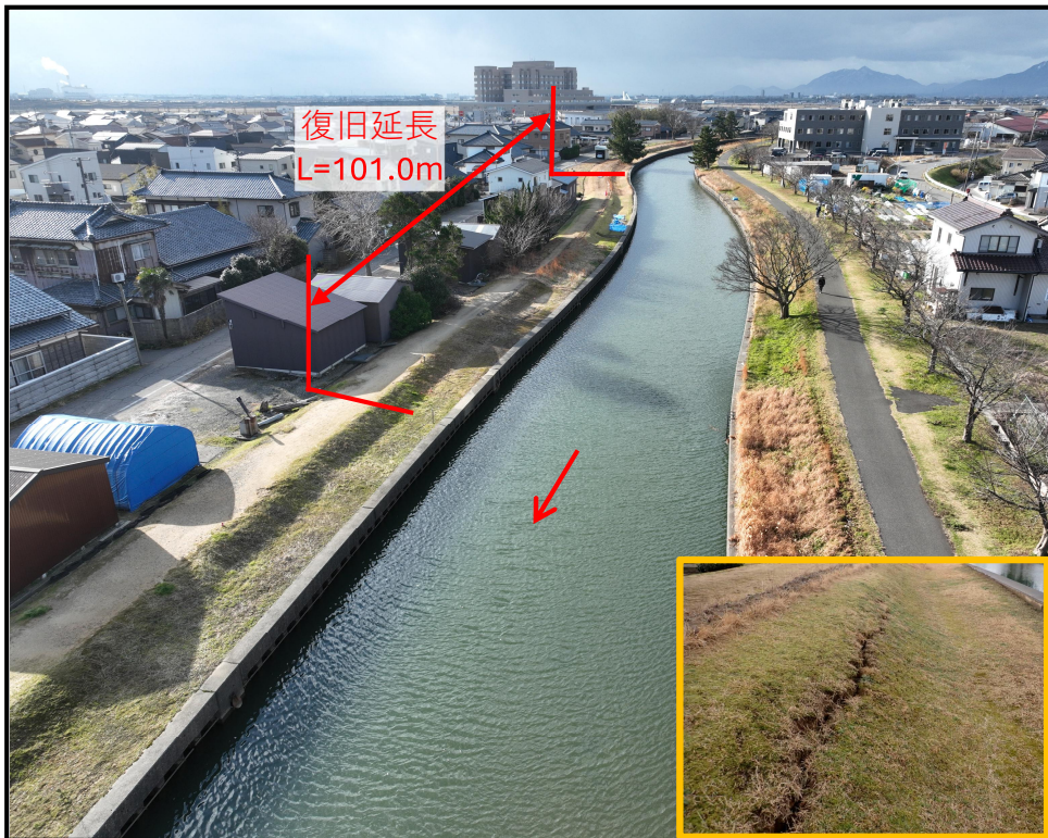
令和6年12月25日 右岸側 起点から上流を望む
