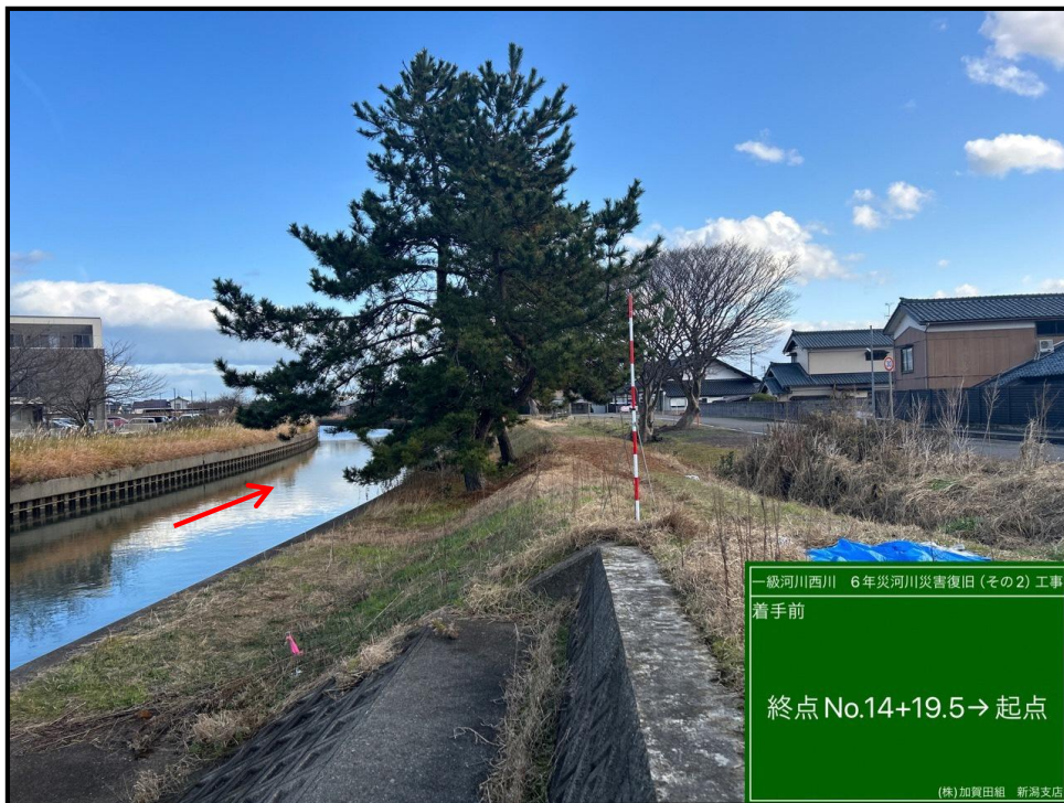
令和6年12月20日 右岸側 終点から下流を望む
