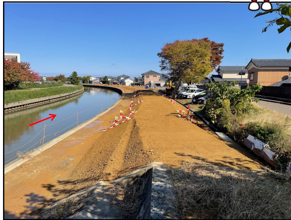
令和7年11月4日 右岸側 終点から下流を望む
