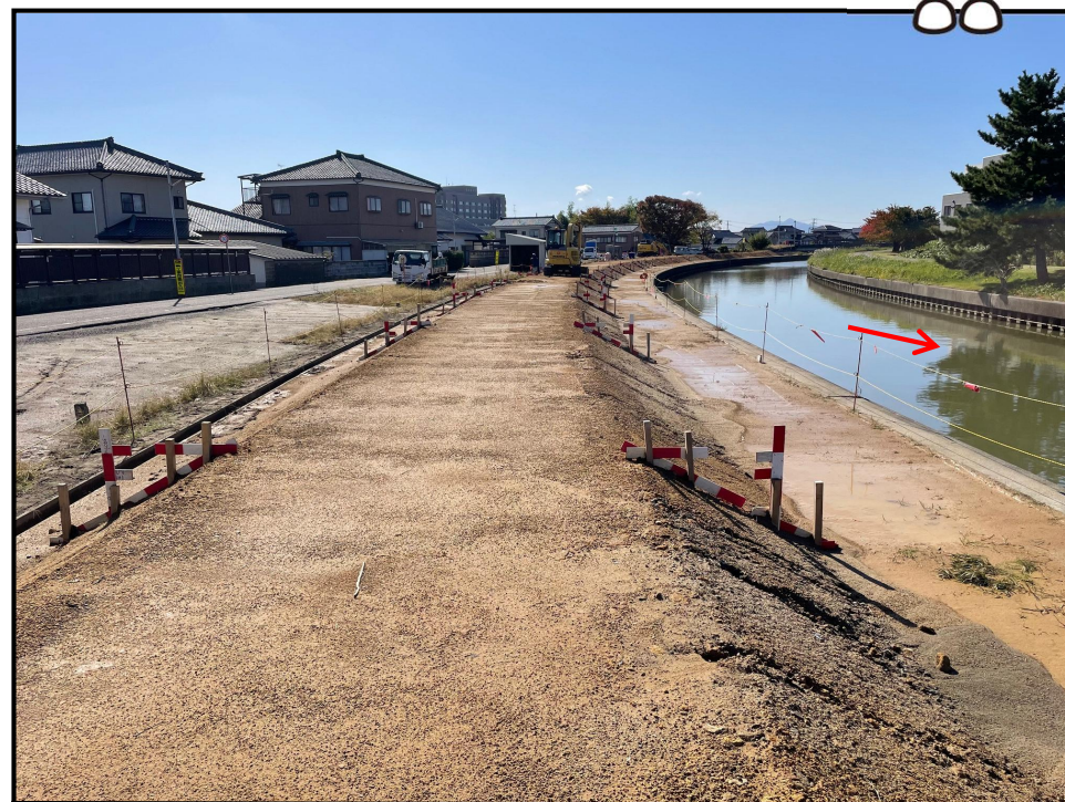
令和7年11月4日 右岸側 起点から上流を望む
