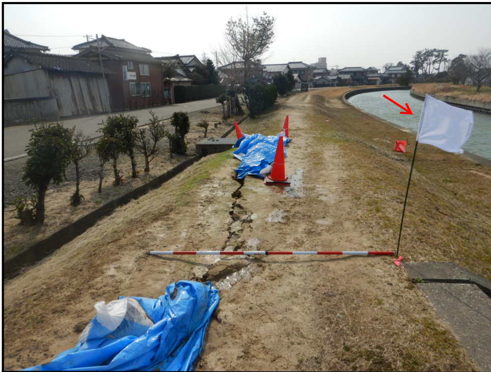
令和7年3月15日 右岸側 起点から上流を望む
