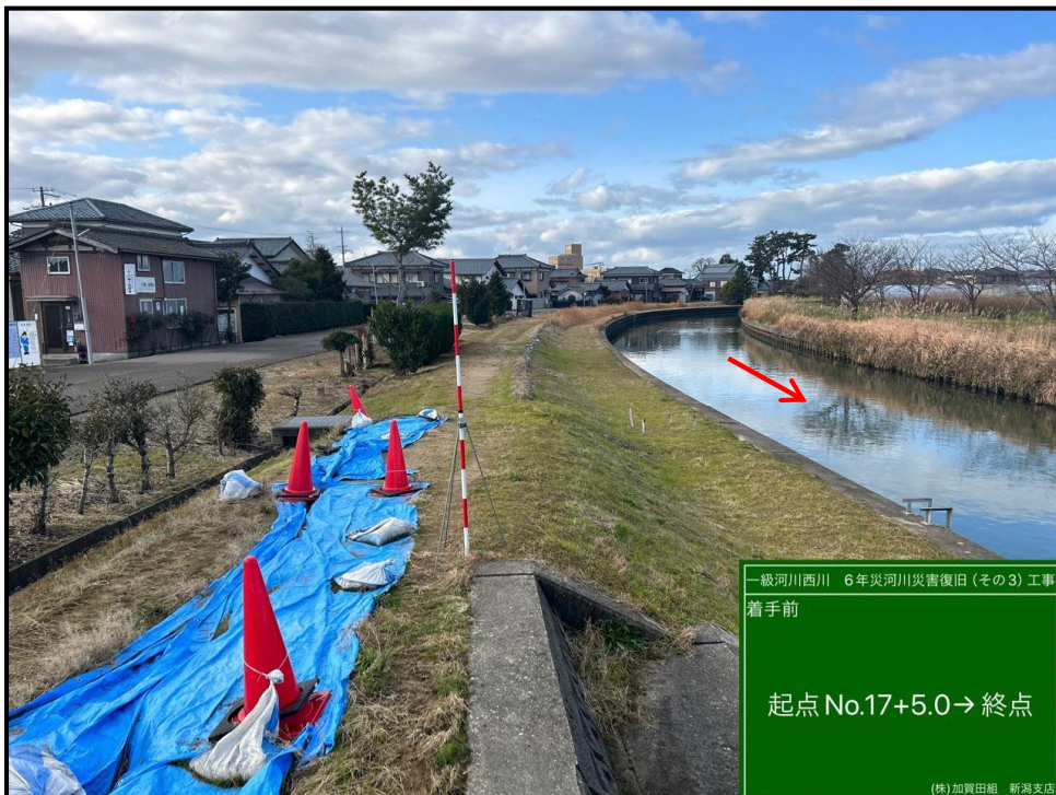
令和6年12月20日 右岸側 起点から上流を望む
