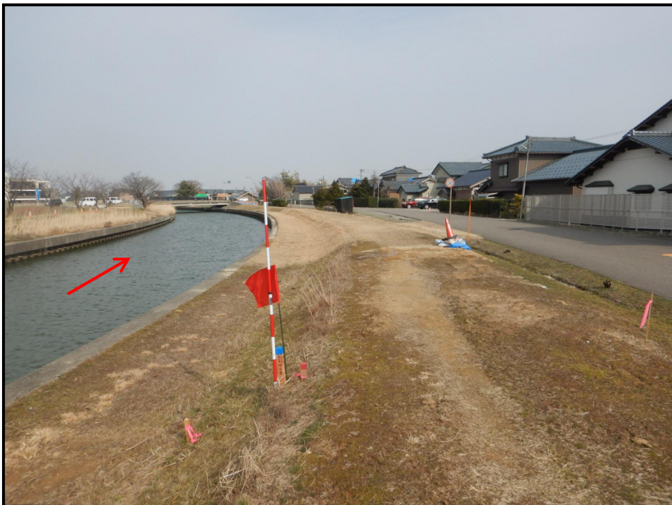
令和7年3月15日 右岸側 終点から下流を望む
