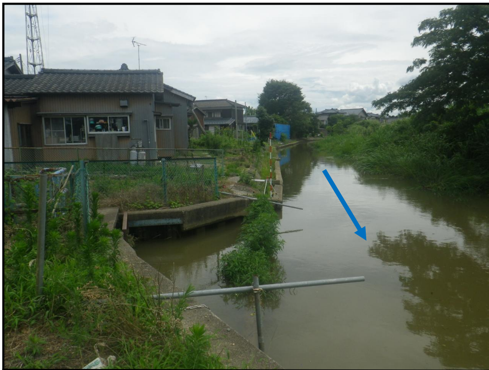
令和6年7月16日 右岸側 起点
