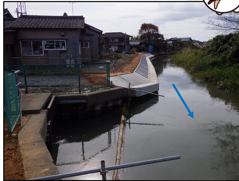
令和6年11月1日 右岸側 起点
