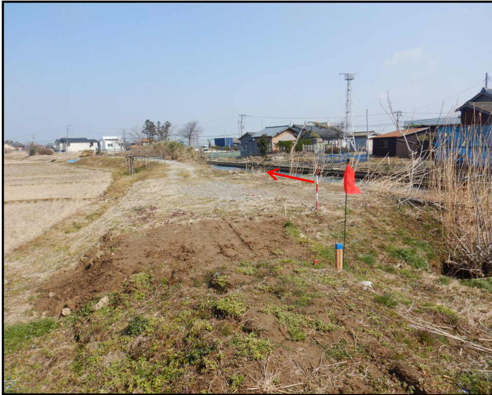
令和6年3月15日 右岸側 終点 から下流を望む
