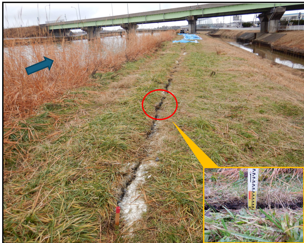
令和6年1月9日 右岸側 終点から起点を望む
