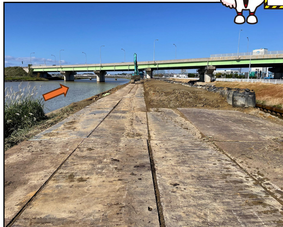
令和7年11月4日 右岸側 終点から起点を望む
