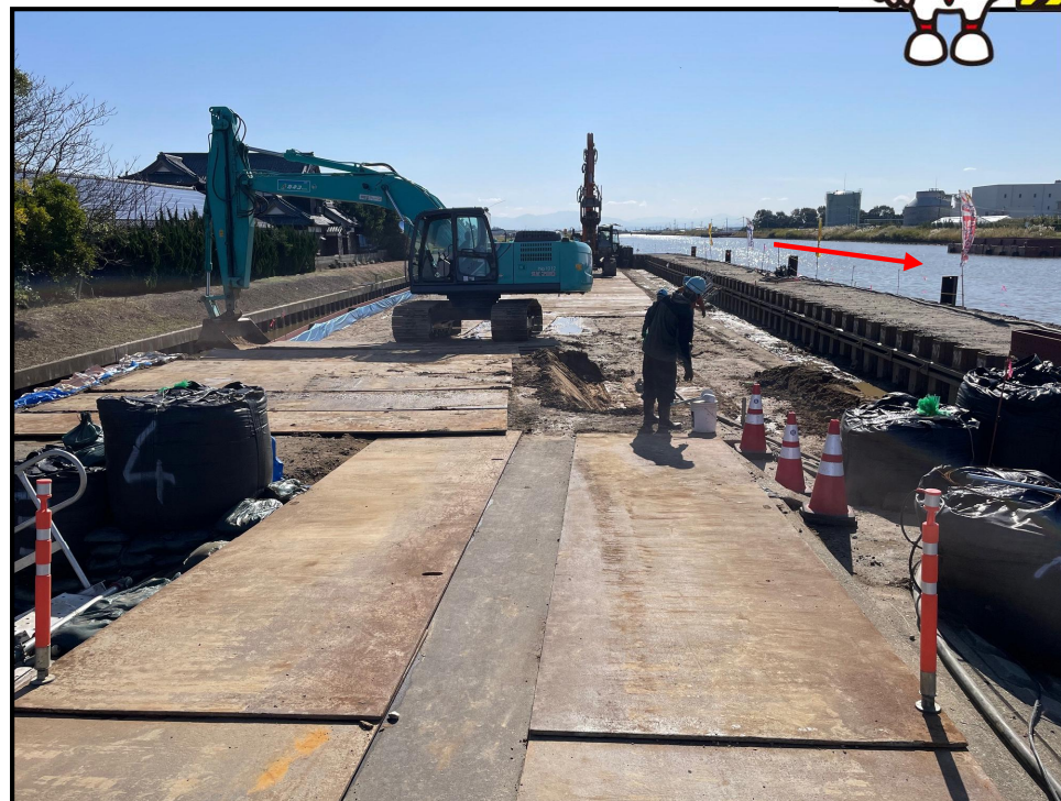
令和7年11月4日 右岸側 起点から下流を望む
