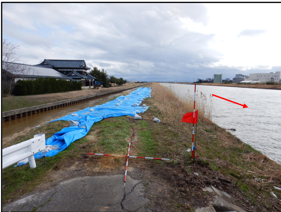
令和6年3月1日 右岸側 起点から下流を望む
