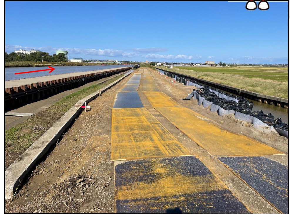
令和7年11月4日 右岸側 笠木橋から下流を望む
