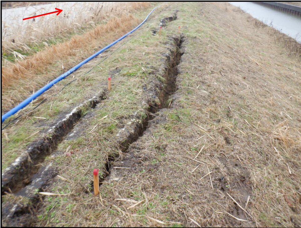
令和6年1月18日 右岸側 笠木橋から下流を望む
