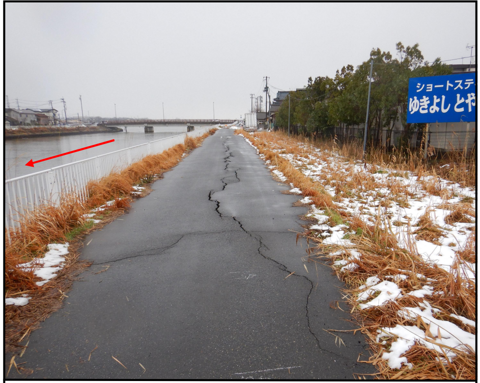
令和6年1月10日 左岸側 起点から上流を望む
