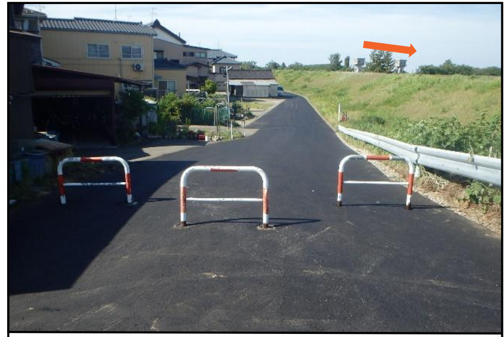
令和6年5月23日 左岸側 管理用道路 終点
