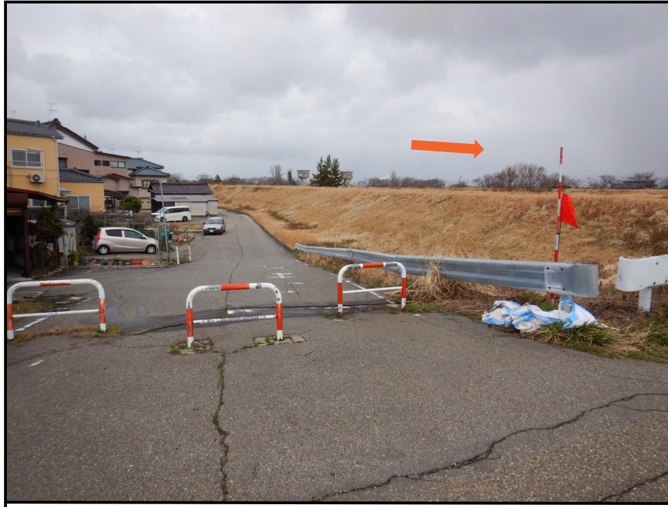
令和6年2月28日 左岸側 管理用道路 終点
