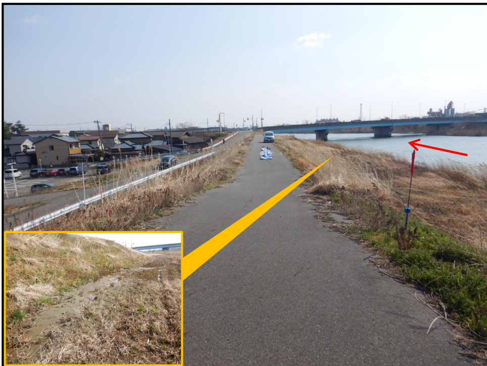
令和6年3月15日 左岸側 終点から下流 大野大橋を望む
