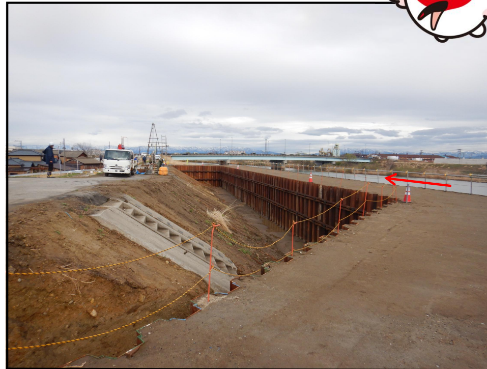
令和7年4月2日 左岸側 終点から下流 大野大橋を望む
