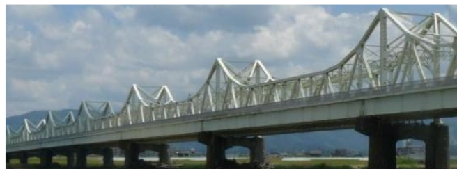
長生橋(一般国道351号)
