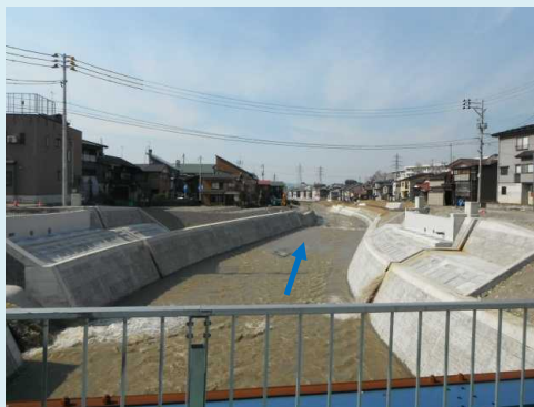
田川橋橋台完成(平成27年4月撮影)
