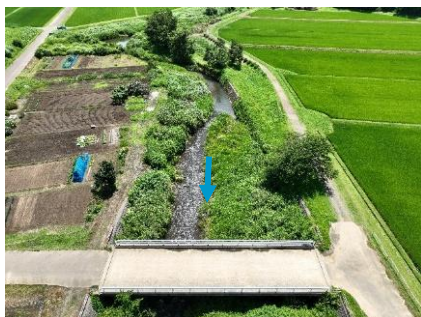
柿崎川(河床掘削前)
