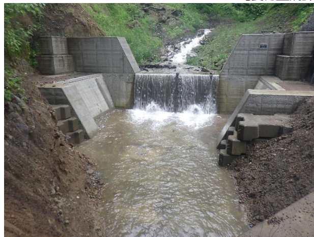
〈地すべり防止対策〉 (堰堤工の設置)
