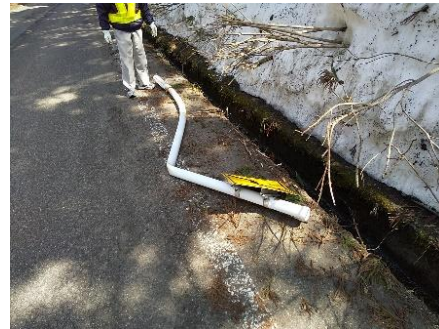
折れた標識の撤去作業
