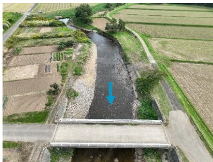
柿崎川(河床掘削後)
