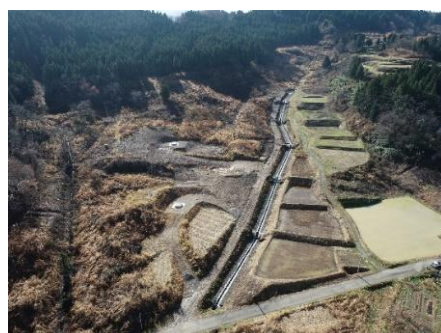
水路工(上越市牧区神谷地内)
