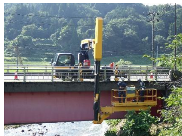
橋梁点検車による橋の点検
