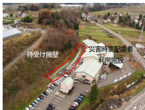
小原新田地区 急傾斜地崩壊対策事業
