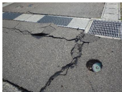
一般県道原之町上下浜停車場線の路面の被災状況 (令和6年1月2日撮影)
