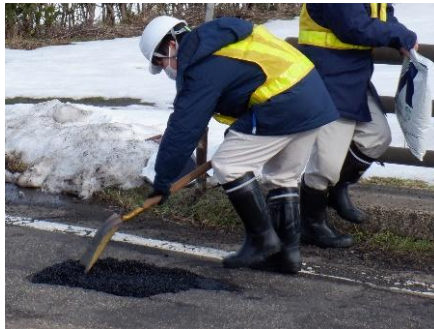
緊急的な舗装穴埋め作業
