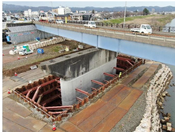
上越大橋P1橋脚補強状況(令和6年4月撮影)
