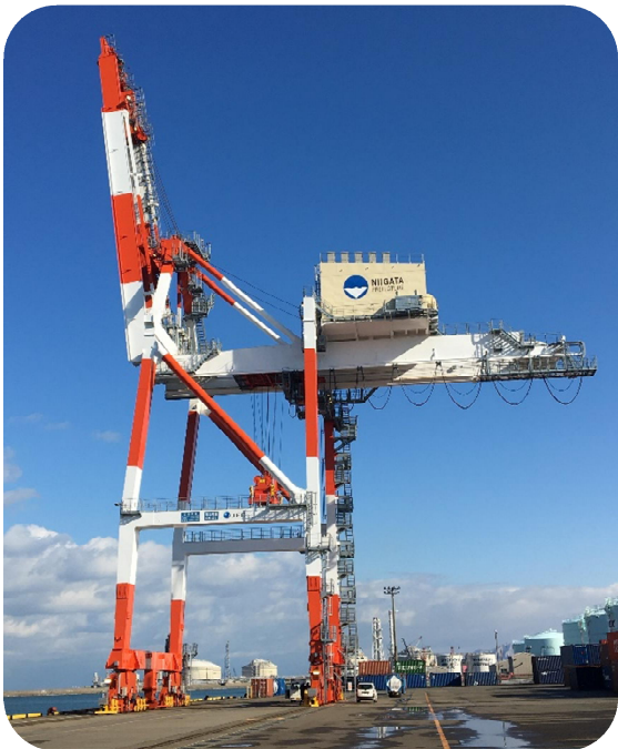
クレーン等の港湾施設も使用許可の対象です。
