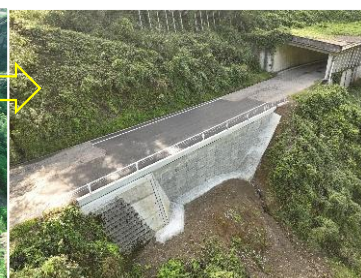
復旧工事後の状況 (R7.9撮影)
