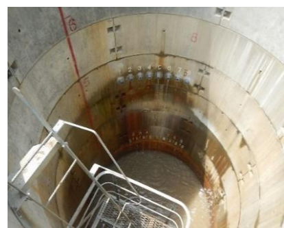
集水井工(上越市牧区倉下地内)
