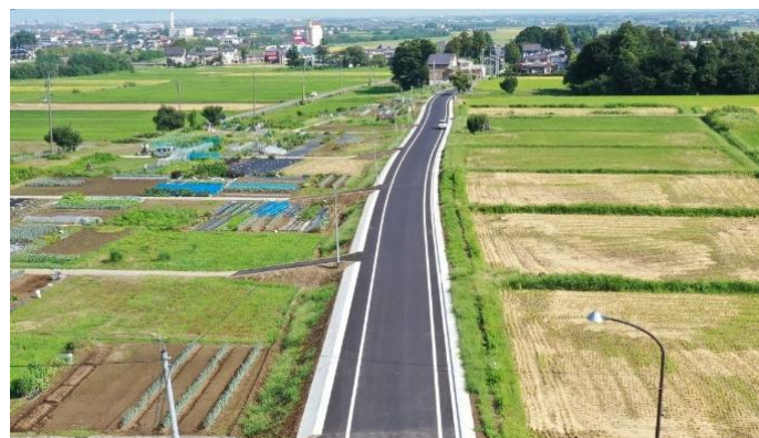
一般県道上小沢北条線(妙高市西条地内)
