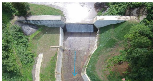
不透過型堰堤・飯田川11号えん堤(上越市牧区宇津俣地内)
