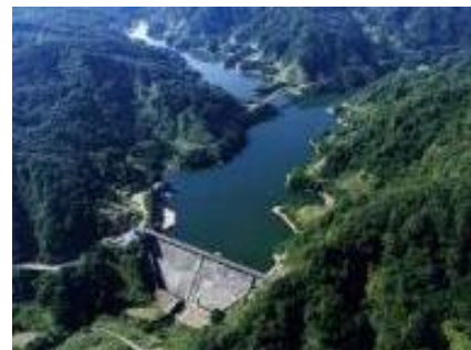
正善寺ダムの全景
