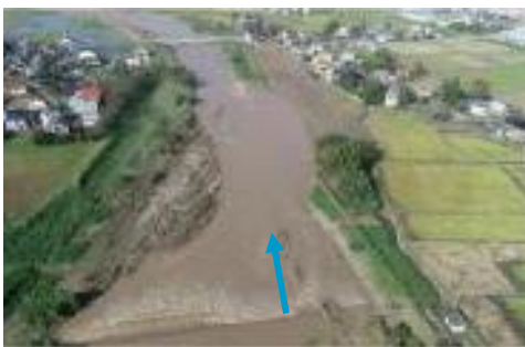
矢代川右岸堤防決壊の状況 (令和元年10月13日撮影)
