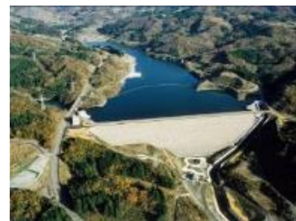
柿崎川ダムの全景
