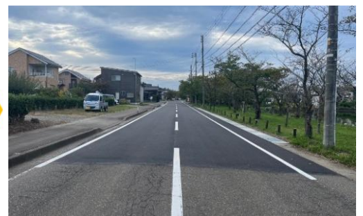
復旧工事後の状況 (令和6年10月撮影)
