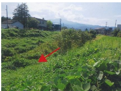
青田川放水路(伐木前)
