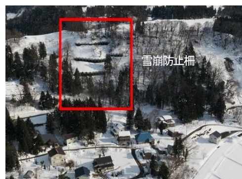
屋敷添地区 雪崩対策事業
