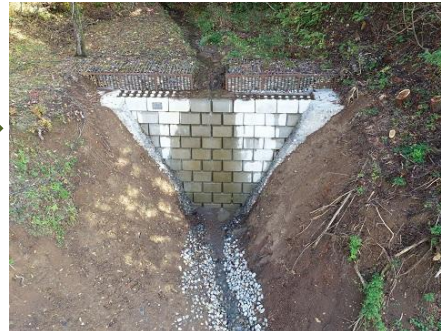
〈施工後 ブロック積による補強 と袖部の保護〉
