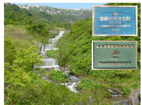
万内川砂防えん堤群
