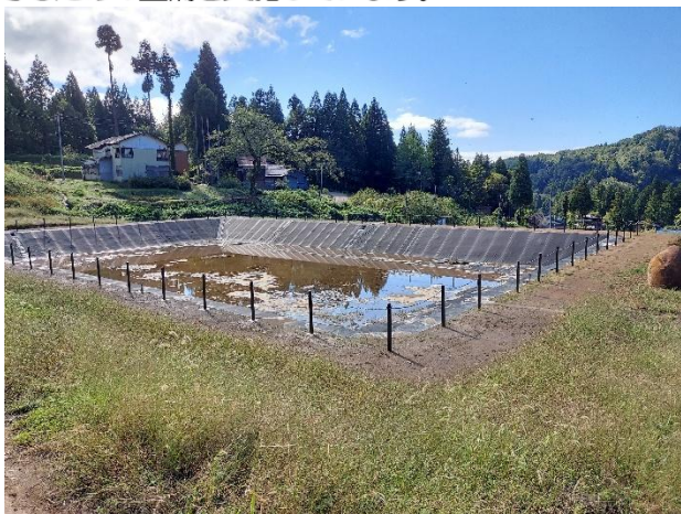
〈農業生産基盤整備〉 (ファームポンドの新設)
