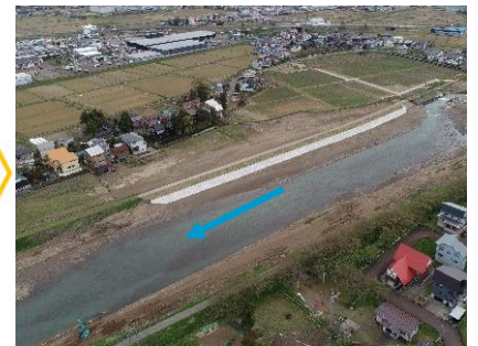
復旧工事後の状況 (令和2年4月撮影)
