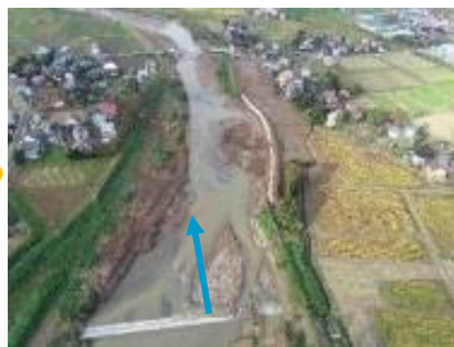
仮堤防工事後の状況 (令和元年10月20日撮影)
