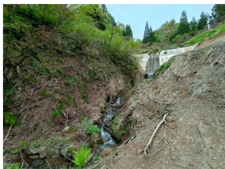
〈施工前 溪流の浸食〉
