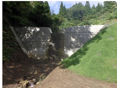
〈施工後 谷止工による浸食防止〉
