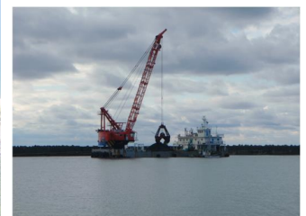
航路泊地 浚渫工事
