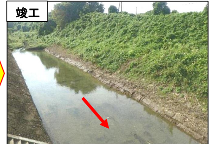
堆積土砂掘削
