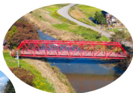
不動沢橋 長岡市不動沢
