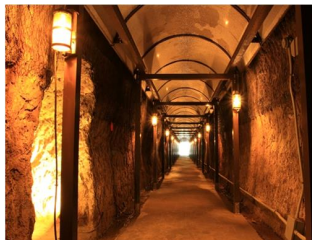
長岡側の坑口付近は見学できます
