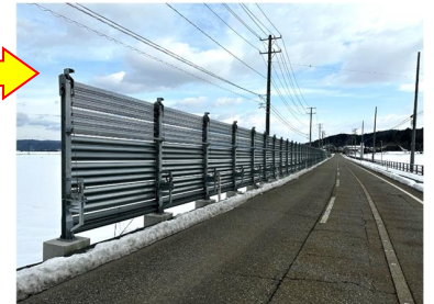
吹き止め柵設置 県道寺泊西山線 長岡市上桐地内
