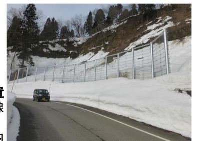
雪崩防護柵設置 県道天納川口線 長岡市 川口牛ヶ島地内
