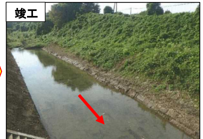
堆積土砂掘削
