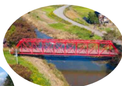
不動沢橋 長岡市不動沢
