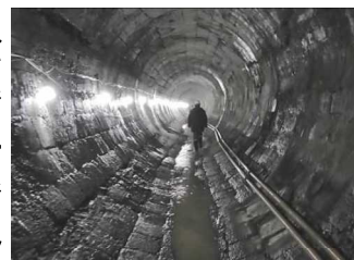
円上寺隧道が建設された当時は、トンネルの覆工材料としてはレンガや石材が主流でした。日本に現存するコンクリート製トンネルでは最古と言われています。
