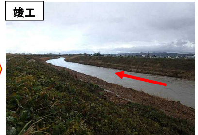
堆積土砂掘削
