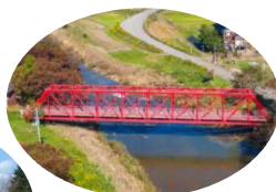
不動沢橋 長岡市不動沢
