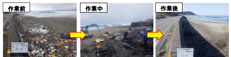
漂着物の撤去 出雲崎町久田地内
