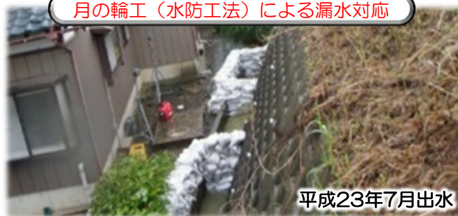
月の輪工（水防工法）による漏水対応
