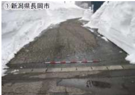
< 舗装損傷状況 >
