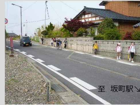
県道坂町停車場線 現道の状況
