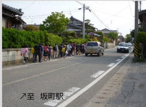
県道坂町停車場線 現道の状況
