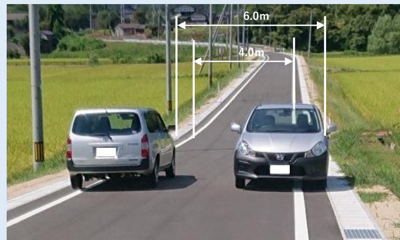
整備後の様子
