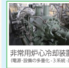
+ 高圧代替注水ポンプ (制御電源不要)
