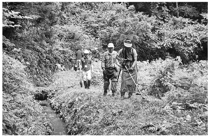
山腹水路の草刈り作業(令和7年6月28日)
