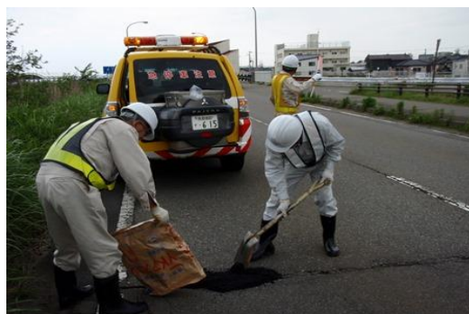
道路パトロール状況
