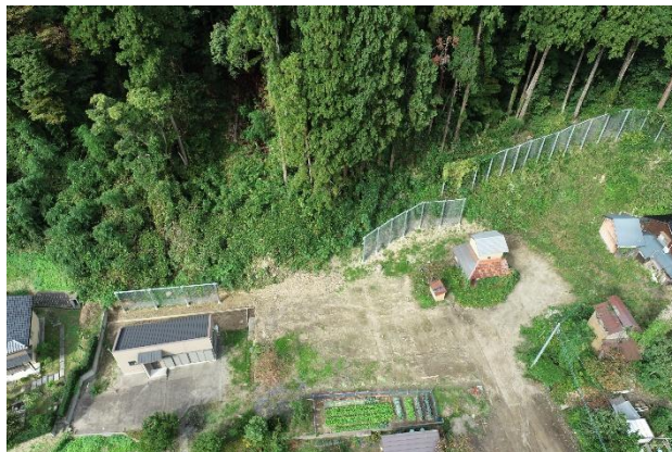
苗代地区（がけ崩れ対策）
