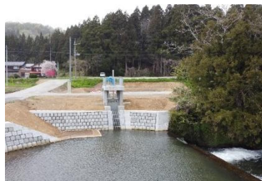
取水口改修(山口頭首工)
