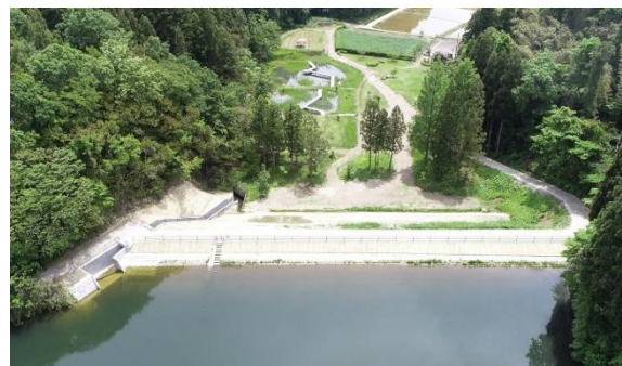
ため池改修(新池)
