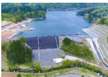
市野新田ダム(国営造成施設)
