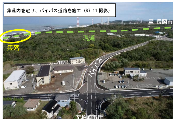
一般国道 352 号 荒浜改良
