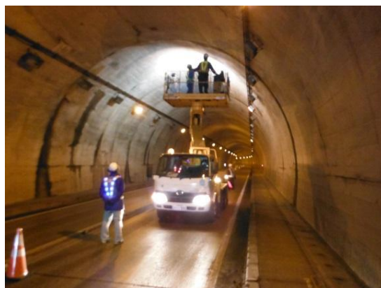
トンネル点検状況
