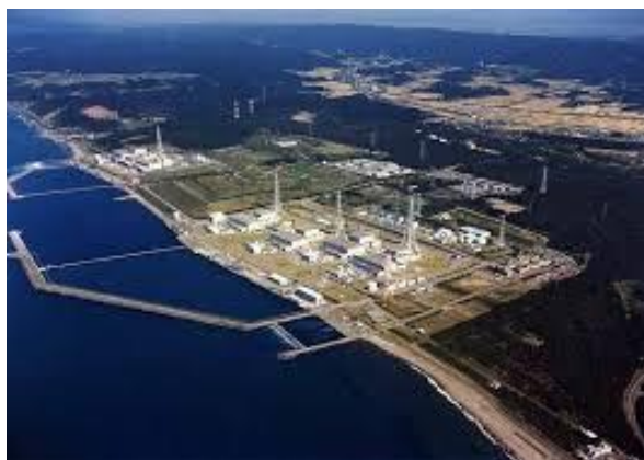
柏崎刈羽原子力発電所全景
