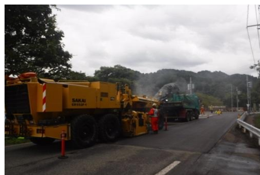
舗装補修工事状況
