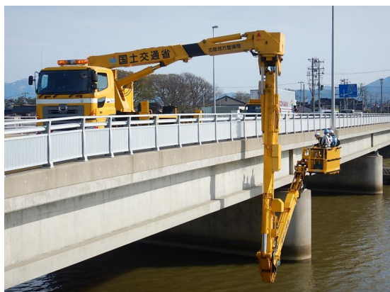
橋梁点検状況
