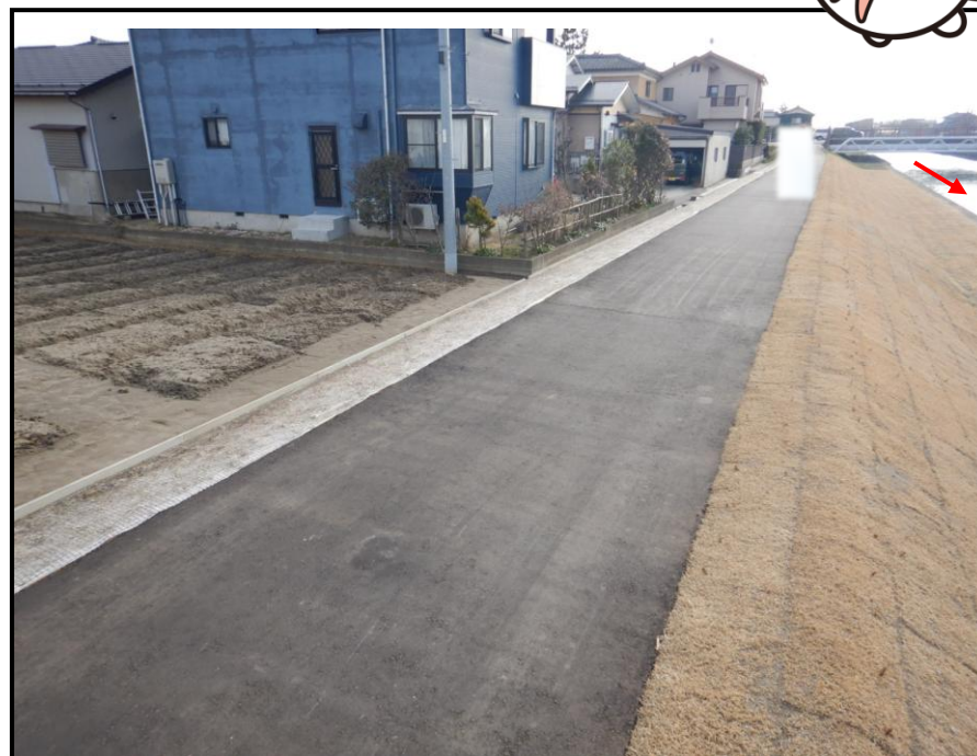
令和8年3月16日時点の復旧状況（中間地点付近）
