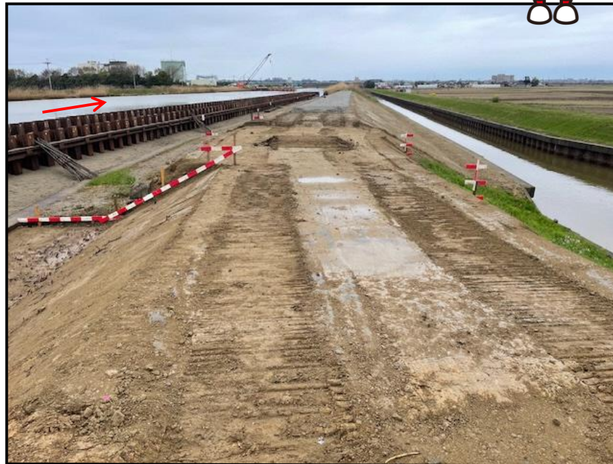
令和8年4月22日 右岸側 笠木橋から下流を望む
